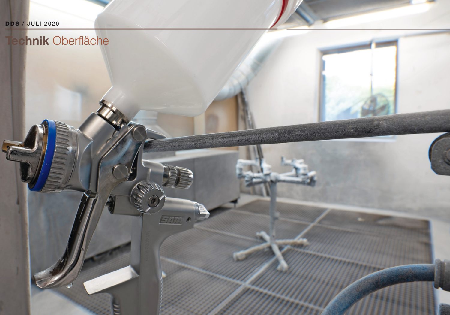
Die Spritzkabine sowie die gesamte Oberflächenabteilung bei Hammermeister ist für Wasserlack ausgelegt
